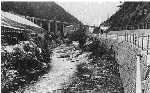
根之谷川の中の岩盤と国道
