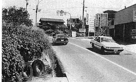
県道上の橋があったところ
