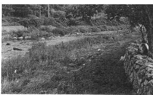
久保湊(上流から)石垣が残る
