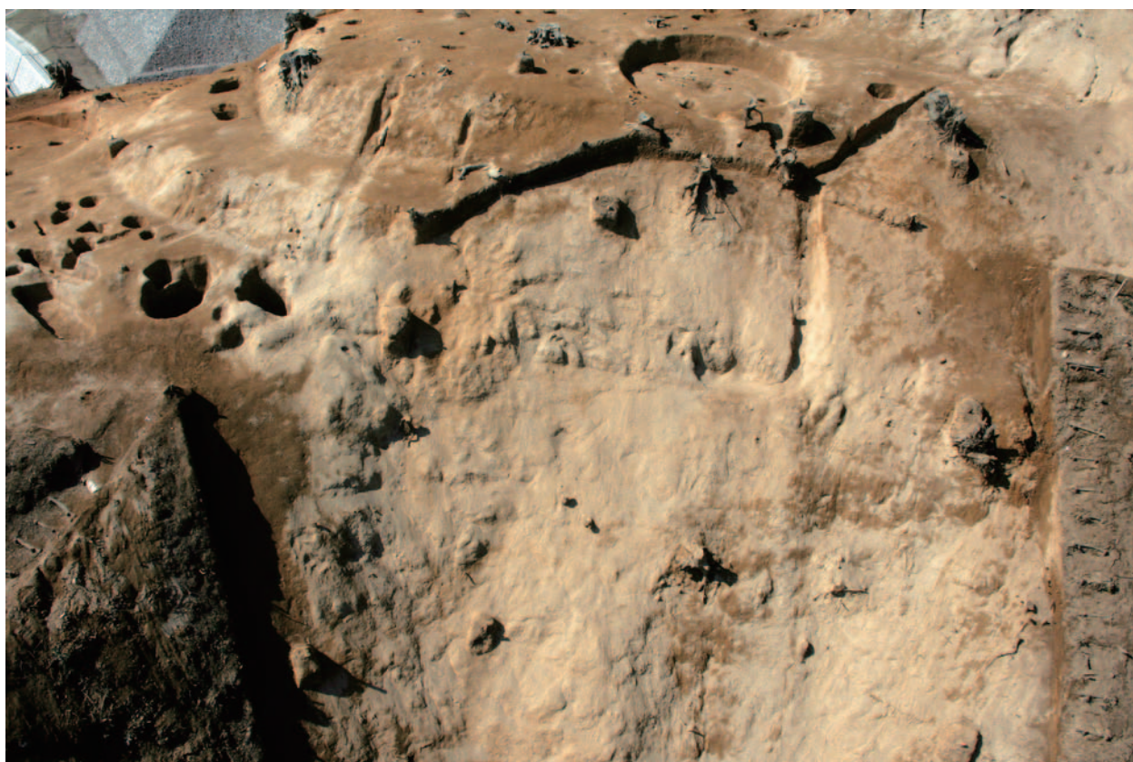
b トンガ坊城跡東側斜面崩落面（航空写真・山城面・東から）
