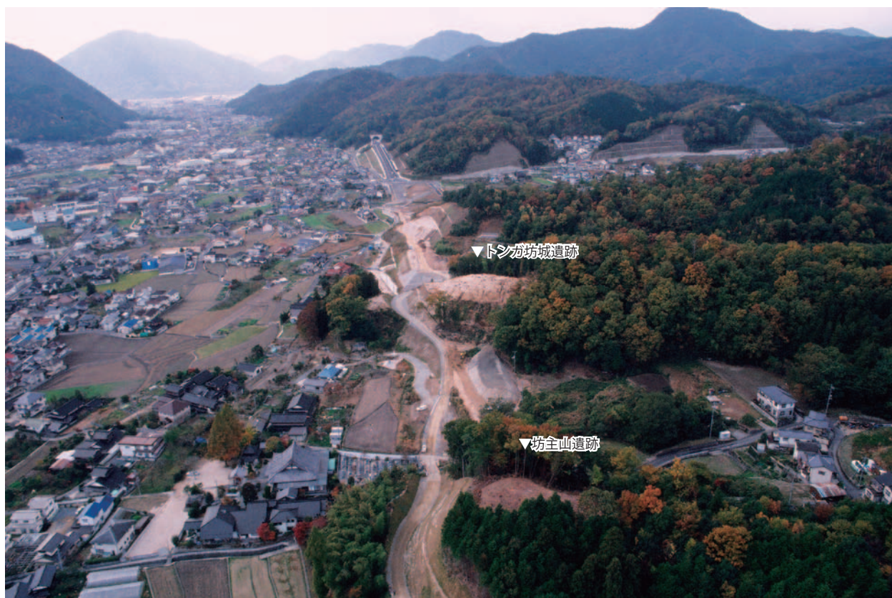
a 坊主山遺跡遠景（航空写真・調査前・北東から）
