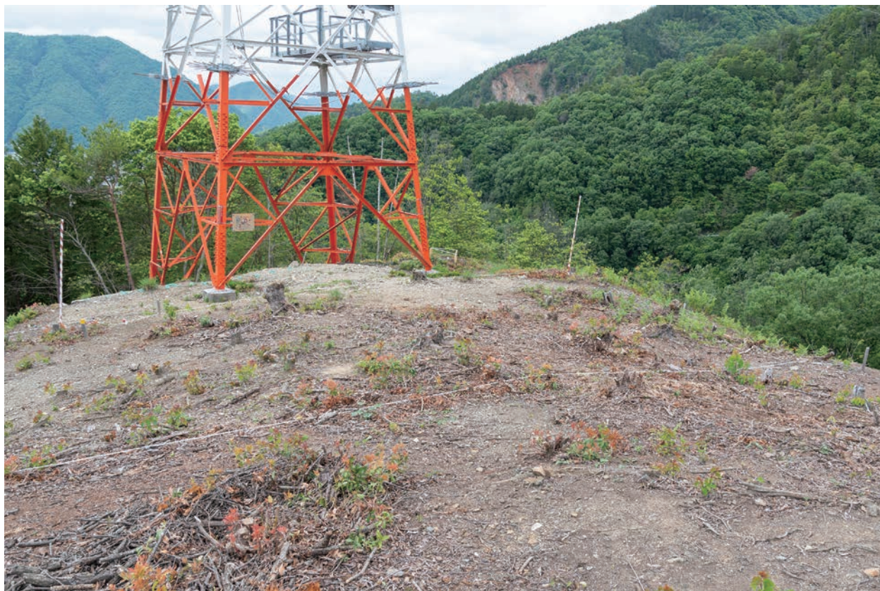
a 調査区 A (調査前・東から)
