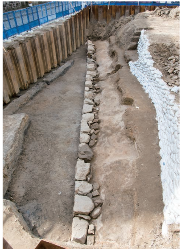
d 石垣栗石除去後（東から）
