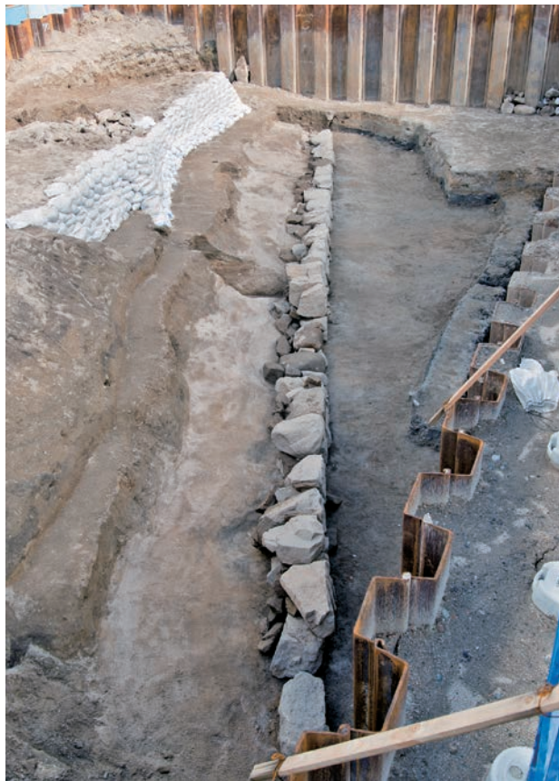
c 石垣栗石除去後（西から）
