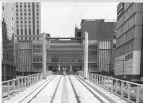
▲「路面電車2階乗り入れ工事の様子」 広島電鉄株式会社 提供
