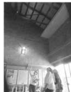
原爆の爆風で曲がった屋根の鉄骨の説明 (昨年の様子)
