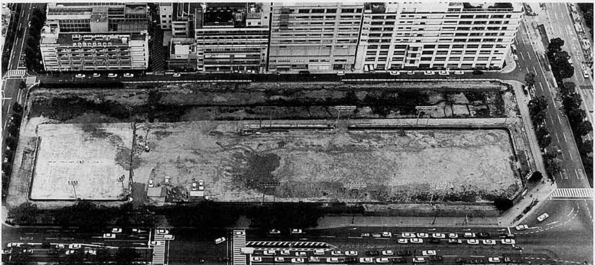
b. 中堀跡全景航空写真（北から）
