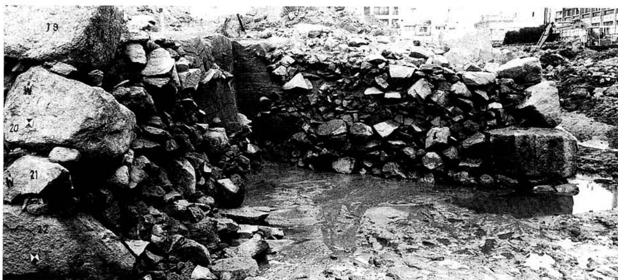
b. 櫓台南西隅裏込め（西から）
