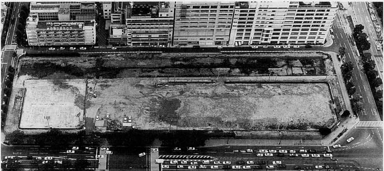
b. 中堀跡全景航空写真（北から）
