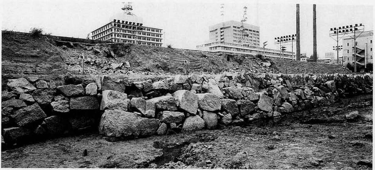
a. 櫓台南面検出時状況
