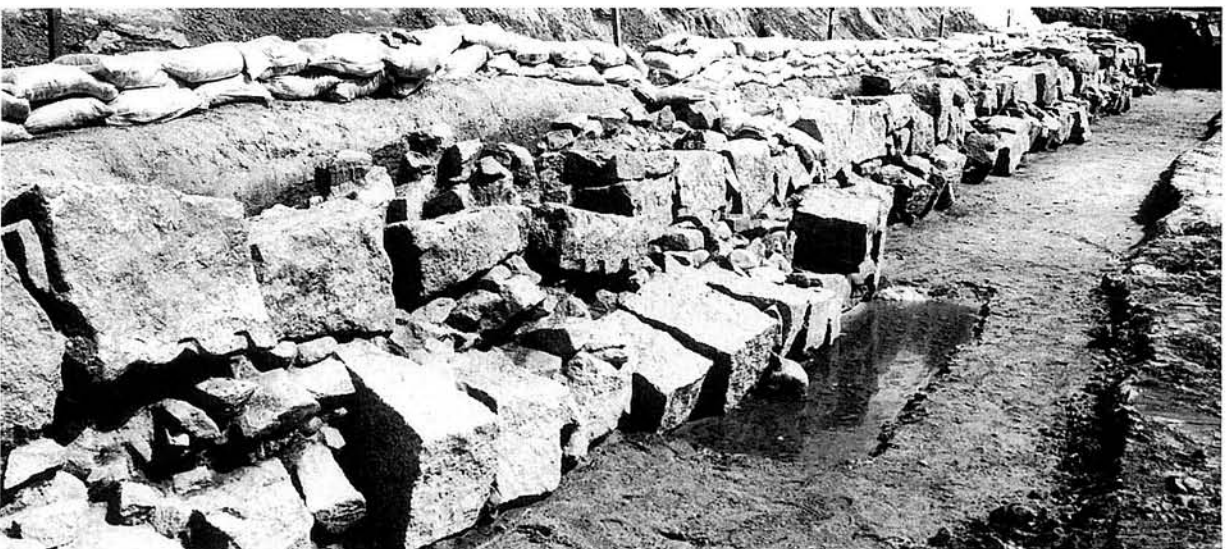
c. N36区以東の石垣列崩落状況
