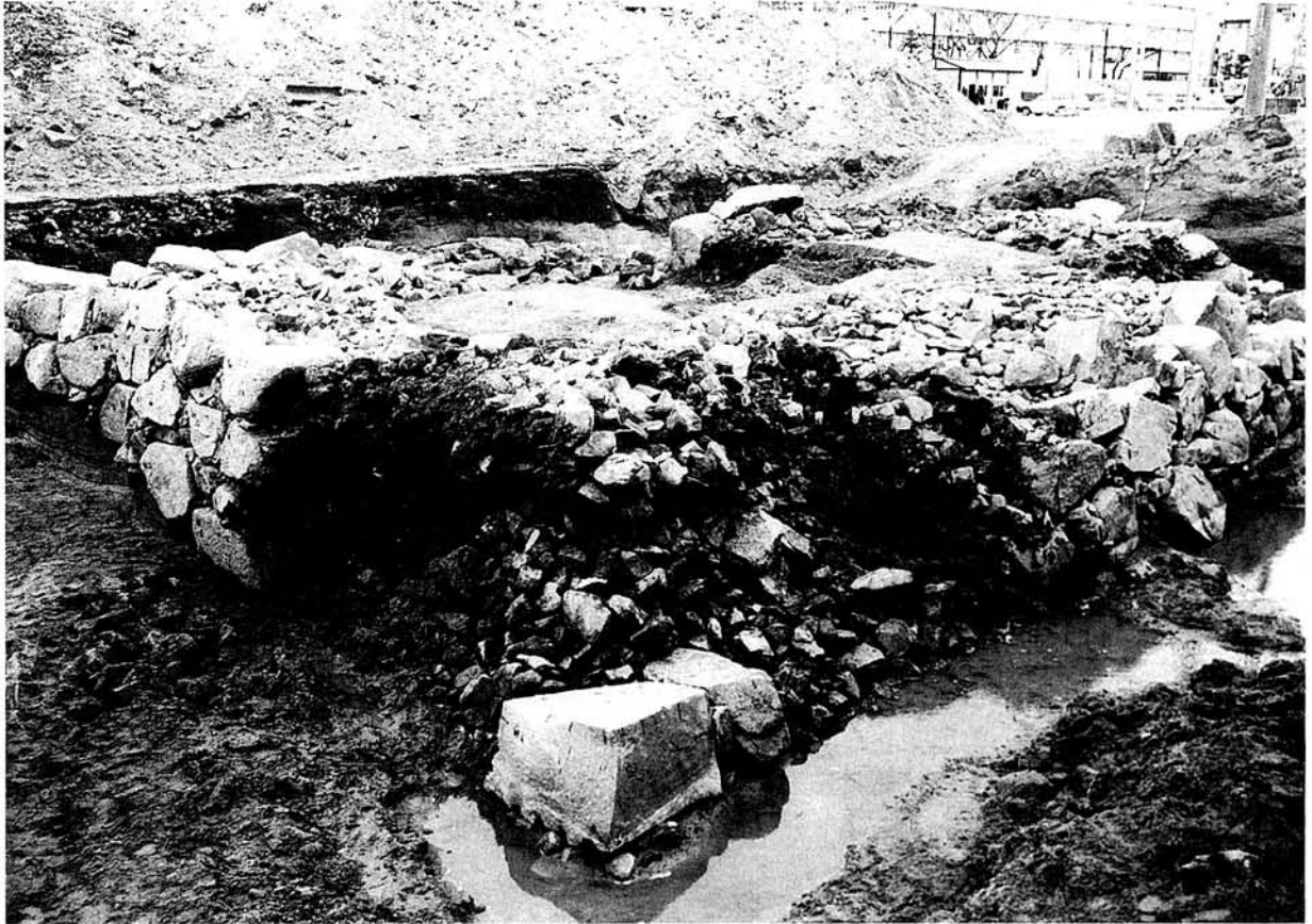
a. 檣台南西隅根石及び裏込め石
