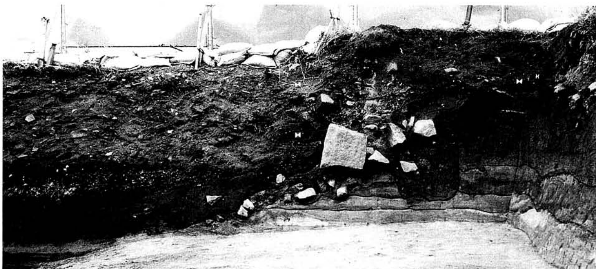
c. S40区東端石垣断面及び堀底
