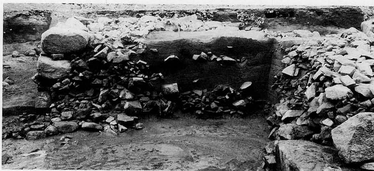
b. 櫓台南西隅裏込め（南から）
