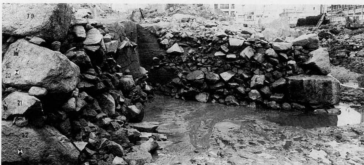
b. 櫓台南西隅裏込め（西から）
