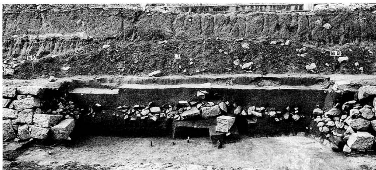
c. N 7 区付近裏込め部完掘状況
