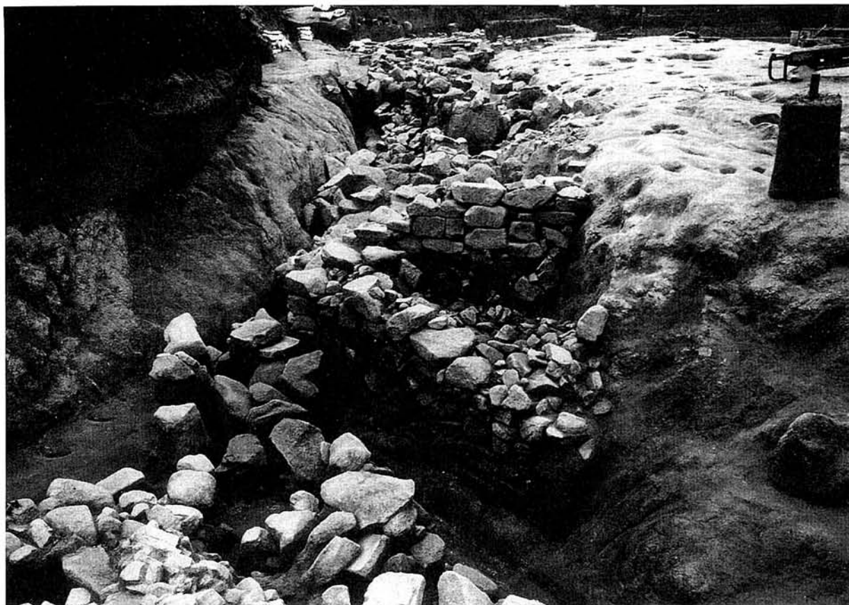
a. 石垣の崩落状況（東から）
