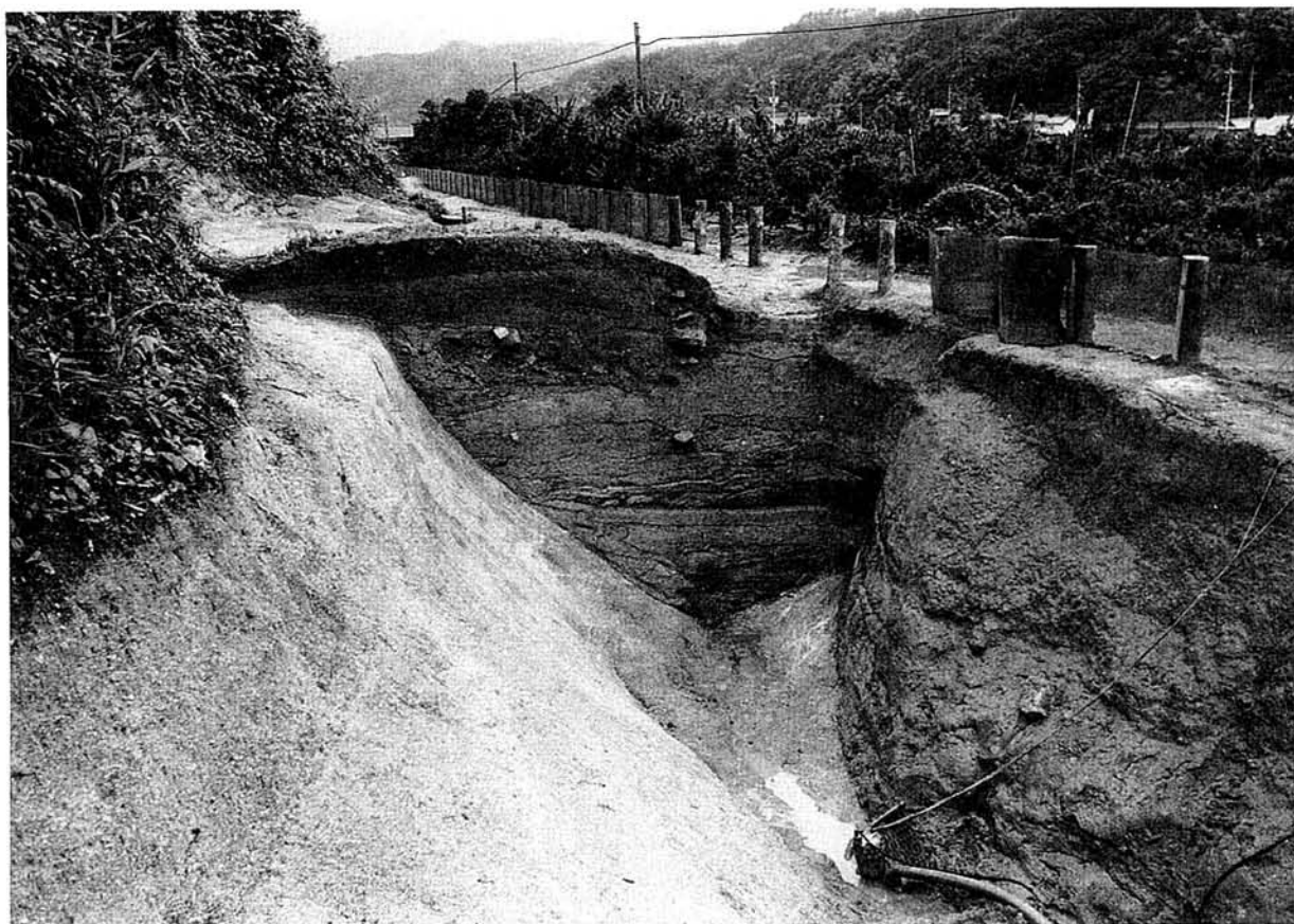
a. 虎口下掘中土層断面（東から）
